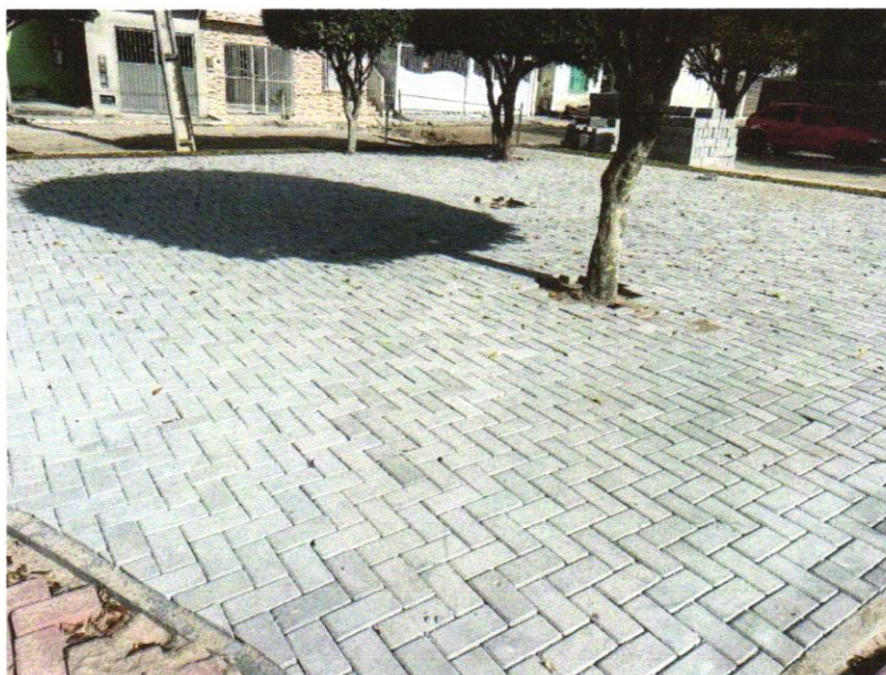
Foto 03 - Pavimentação em bloco de concreto vibroprensado, intertravado, cor natural, 10x20cm, e=6cm, 46un/m 2 , NBR9781, Fck(min)=35MPa, sob coxim areia grossa compactada c/ placa vibratória, e(comp.)=6cm, rejuntado c/ areia fina.
